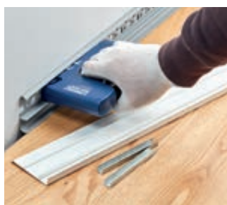
Na zszywki Installation with staples Heftklammerbefestigung
