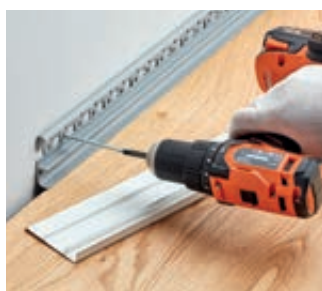
Na kołki rozporowe Wall plug installation Mit Dübeln
